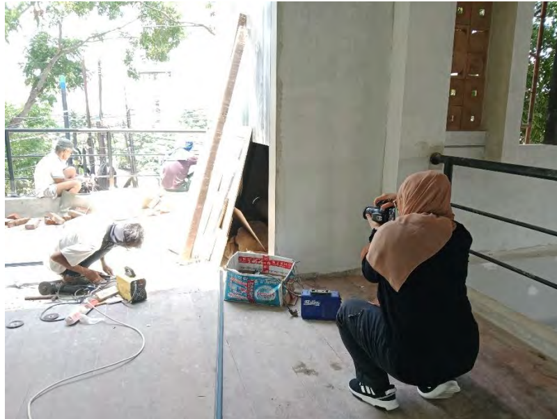
Gambar 22. Pengambilan gambar di Proyek Jl. Soekarno Hatta (Foto: Ananda, 14 Oktober 2024)
