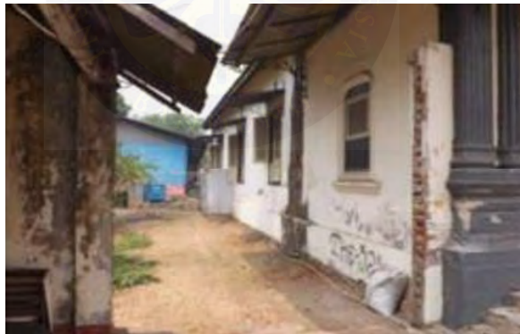
Gambar 4. 6 Kondisi Paviliun Sisi Kanan
