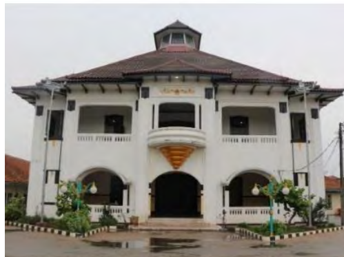
Gambar 4.4. Tampak Depan Museum Gedung Juang 45 Bekasi
