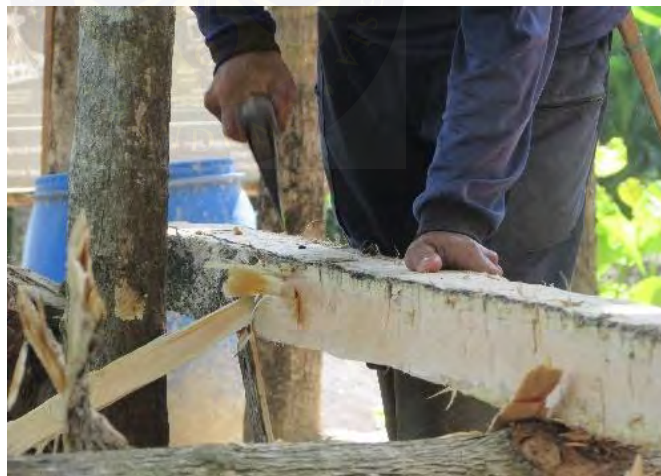
Gambar 4. 3. Proses Pemasangan Kayu
