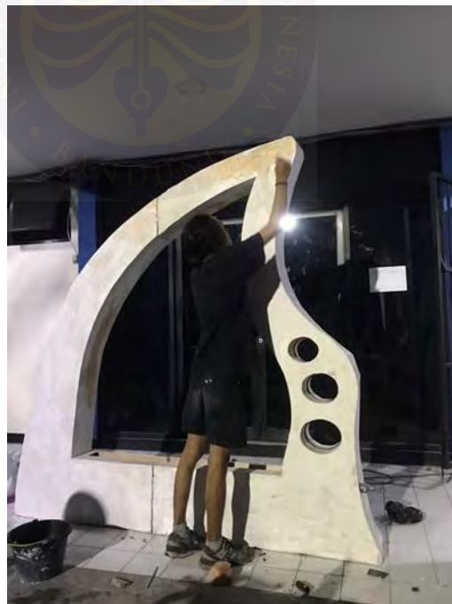
Gambar 2. 27 Proses dempul
