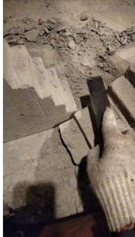
Gambar 3.19 “Pemahatan batu hebel”
