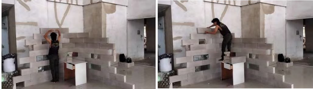
Gambar 3.18 “Penyusunan batu hebel”
