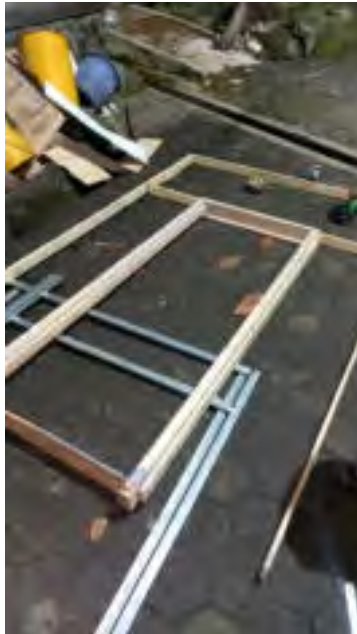
Gambar 73. Gambar proses pengerjaan pintu
