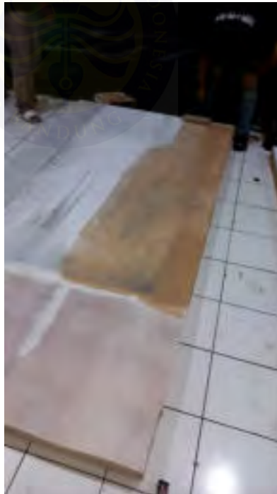
Gambar 76. Gambar pengecatan dinding
