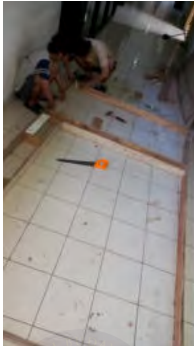
Gambar 71. Gambar proses pengerjaan dinding
