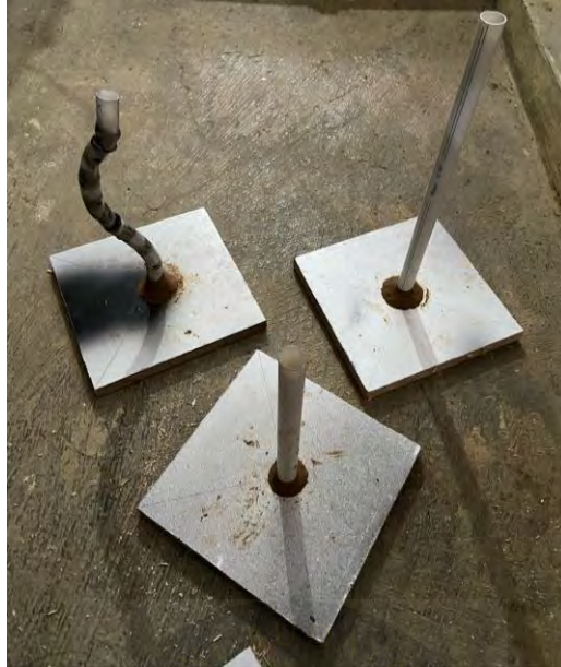
Gambar 2.34 Pemasangan pipa tulang base ke bagian dasar base
