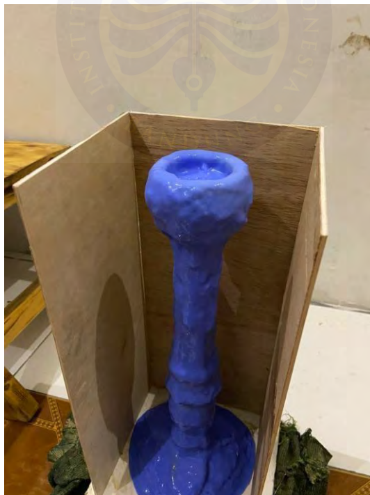
Gambar 2.40 Pemasangan triplek untuk dinding pengecoran gypsum
