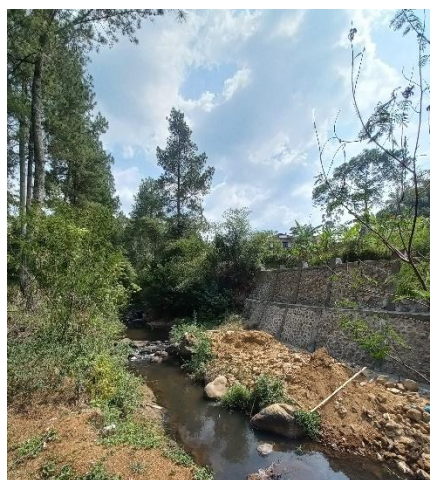
Gambar 37. lokasi di renovasi (Sumber: Dokumentasi Pribadi, Pada 14 Oktober 2024)
