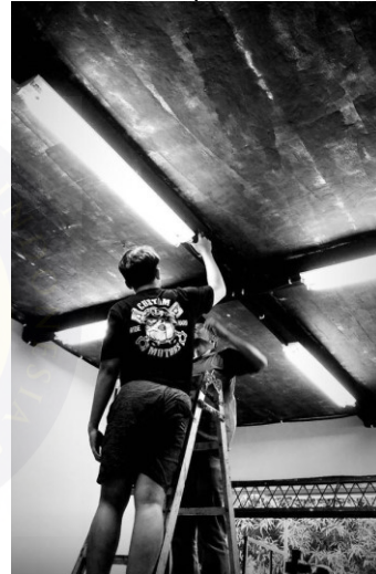
Gambar 4.1. 5 Proses renovasi bangunan
