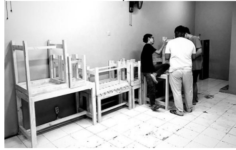
Gambar 4.1. 3 Proses renovasi bangunan
