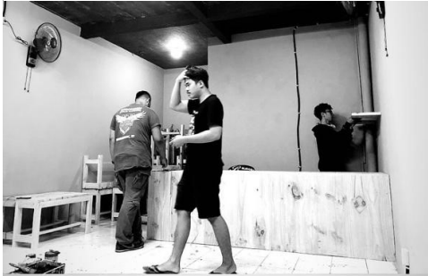
Gambar 4.1. 2 Proses renovasi bangunan
