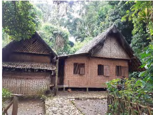
Gambar 4.2 Bangunan Rumah Adat Cikondang
