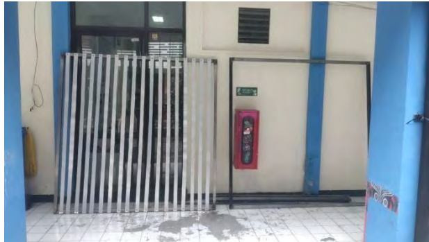
Gambar 3.5 Proses Pemasangan Alumunium
