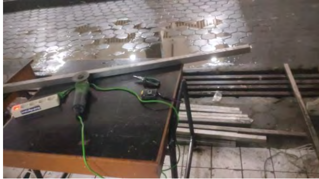
Gambar 3.1 Proses Pemotongan Besi
